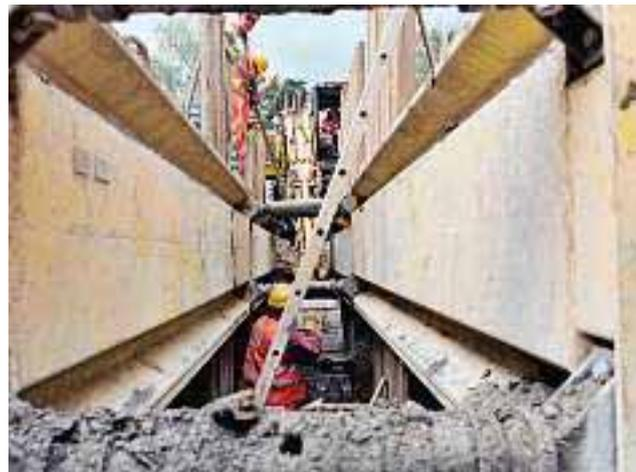
La luce dello scavo deve misurare come minimo 60 cm in ogni fase dei lavori di scavo.
