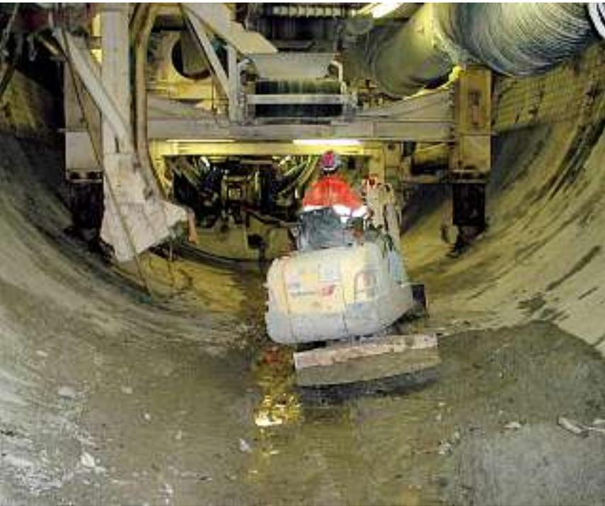
Fig. 3: lavori di avanzamento al di sotto della TBM
