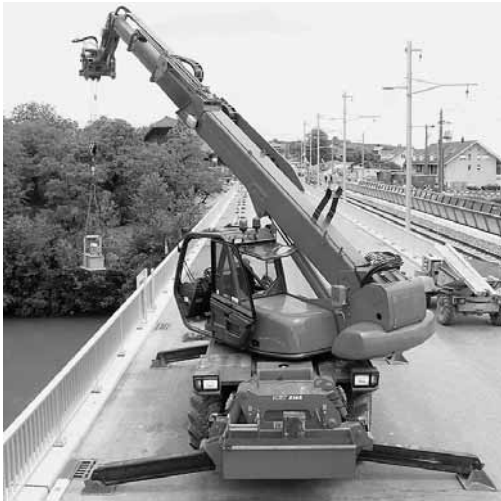
Bild 5 Fahrzeugkran: Teleskopstapler mit Seilwinde
