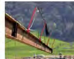
3 Réduire au maximum le temps de travail avec une protection par encordement grâce au pré-montage.
